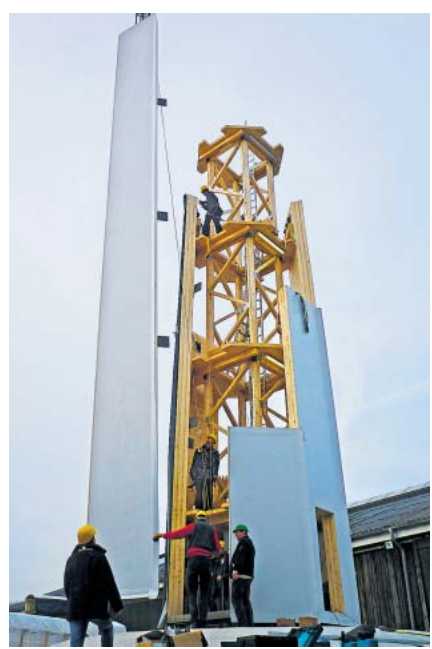
In verkürzter Form: Errichtung eines Testturms aus Holz Foto Timber Tower
